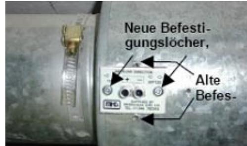
Utiliser le nouveau capteur de pression différentielle :
