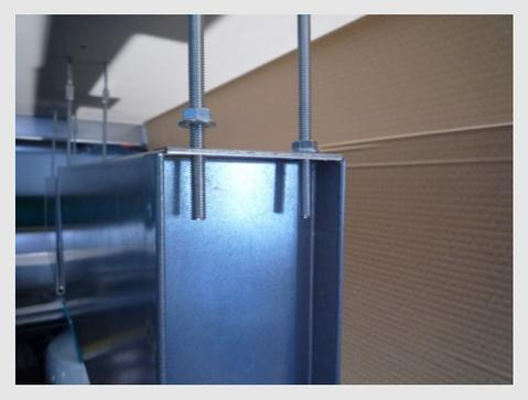
Monter les tôles de raccordement du caisson (fig. 2.2 - 2.3)
