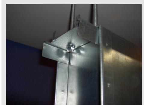
Orienter et fixer le caisson à l'aide des écrous.
